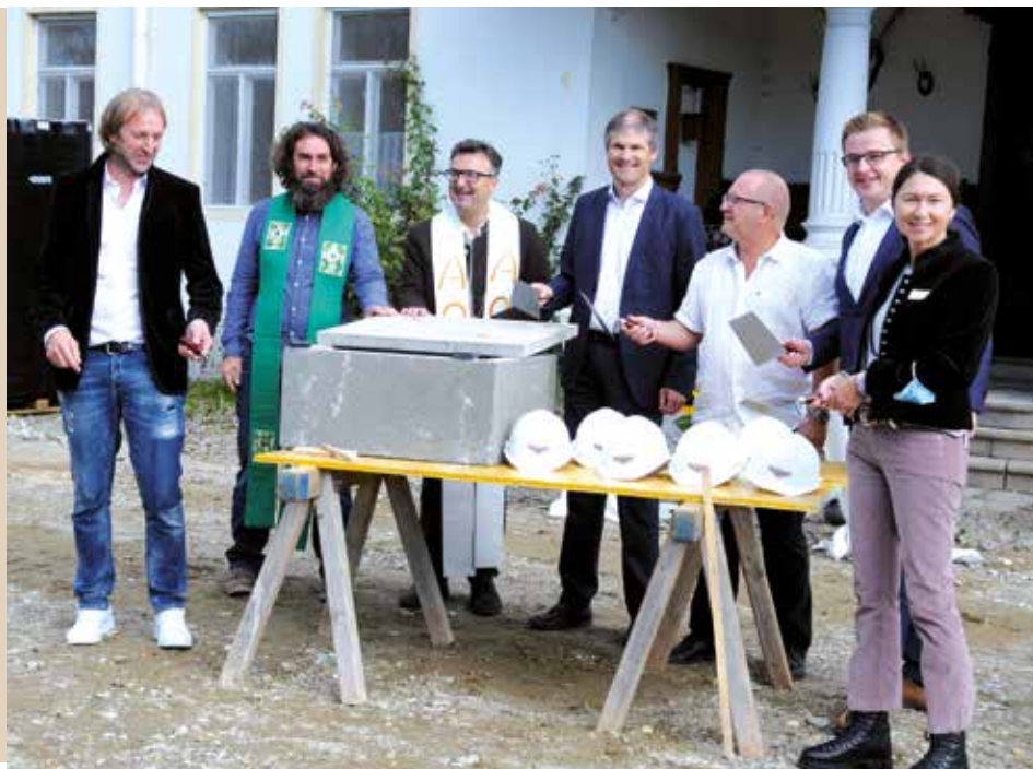
v.l. Stefan Mayer, die Pfarrer Michael Krauß und Christoph Rudolph, Mirko Gruber, Peter Dörr, Bürgermeister Christoph Schneider und Theresa Mayer verstaute ein Rohr, gefüllt mit Bauplänen in einem Betonblock. Das von ihnen vermauerte Archiv findet seinen Platz im Fundament des Pavillons.
